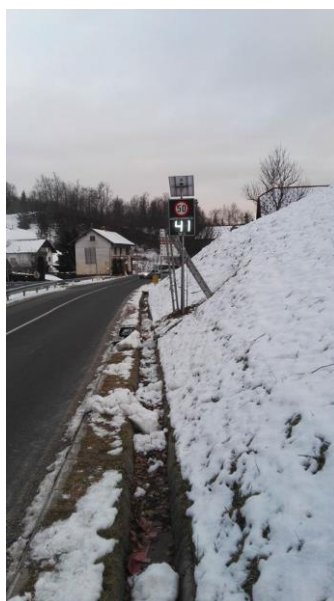
Slika 6: Opozorilni sistem COPS@road ob regionalni cesti
