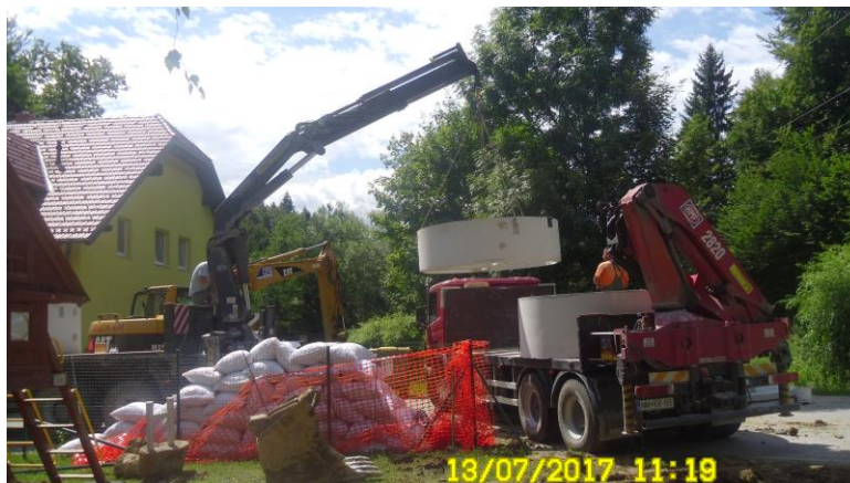
Slika 2: Vgradnja čistilne naprave pri OŠ Dobje
